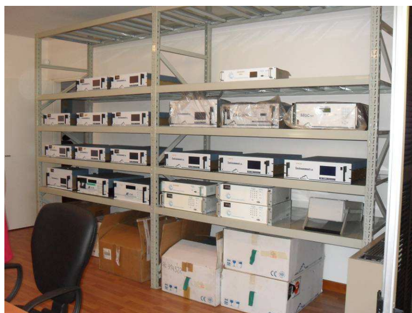
▲ Analyseurs en maintenance dans les locaux de Scal-Air
