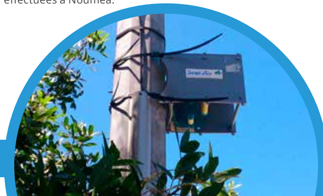
Tubes passifs BTEX installés sur un lampadaire.
