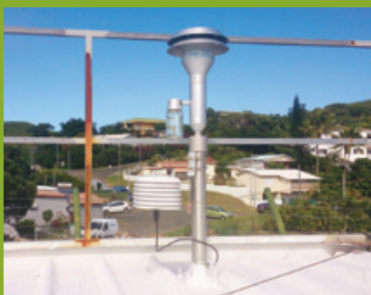
Toit de la station de Logicoop remis à neuf
